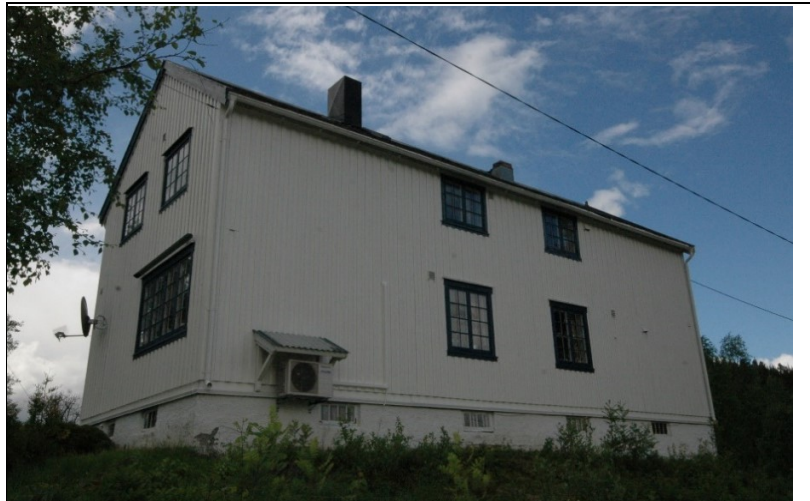
Bildet viser brakken som er søkt ombygd
