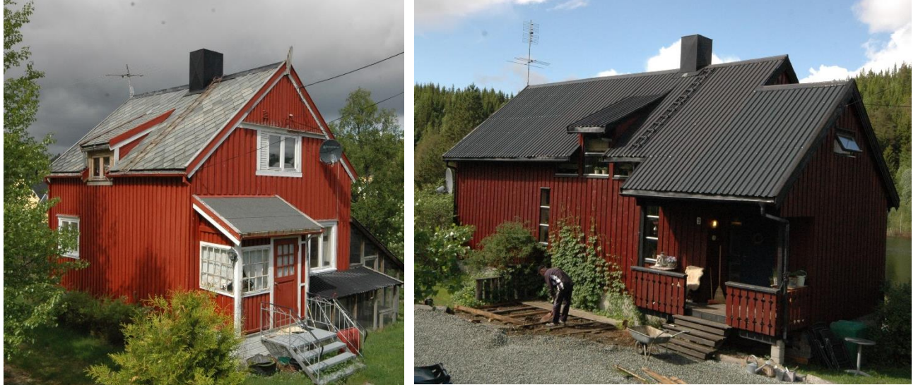
Venstre: opprinnelig bygningsvolum på typehus A. Høyre: Ombygd typehus A. Eksempel på endringer som gjør opprinnelig volum og type lite lesbar. Foto: Hauke Haupts, Trøndelag fylkeskommune
