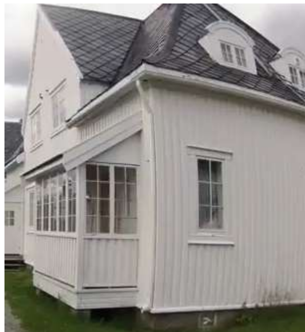
Takrenner og nedløpsrør males i husets hovedfarge.
