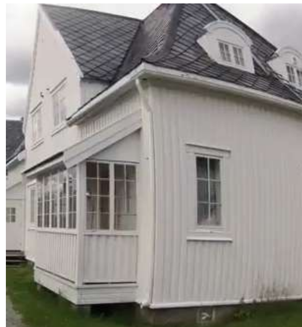
Takrenner og nedløpsrør males i husets hovedfarge.
