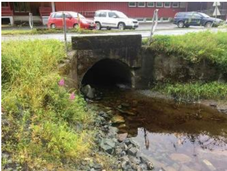
Figur 21. Grøta bekken, innløp til kulvert som går under Ressveien. Kulvert er ca 1,5m høy og 2,0m bred.
