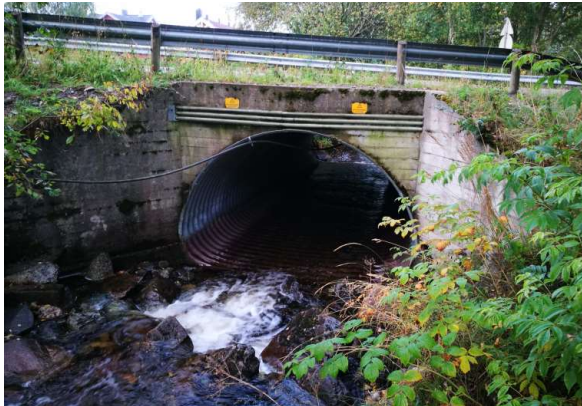
Messa, kulvert under Fv. 501.
