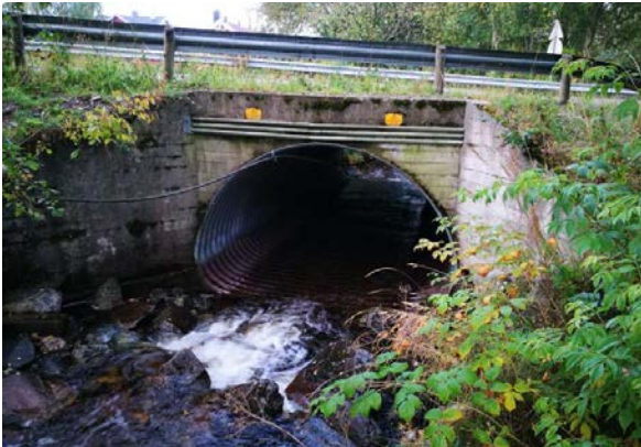
Messa, kulvert under Fv. 501.
