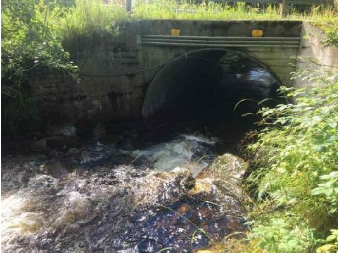
Figur 23. Bjørnslibekken/Messa, innløp til kulvert som går under Ressveien.
