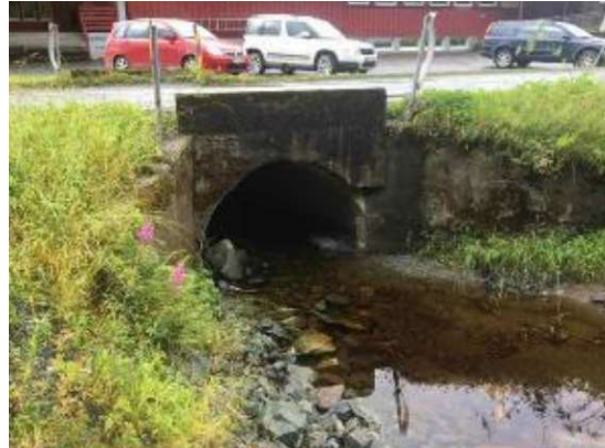
Grøta, kulvert under Fv. 501.
