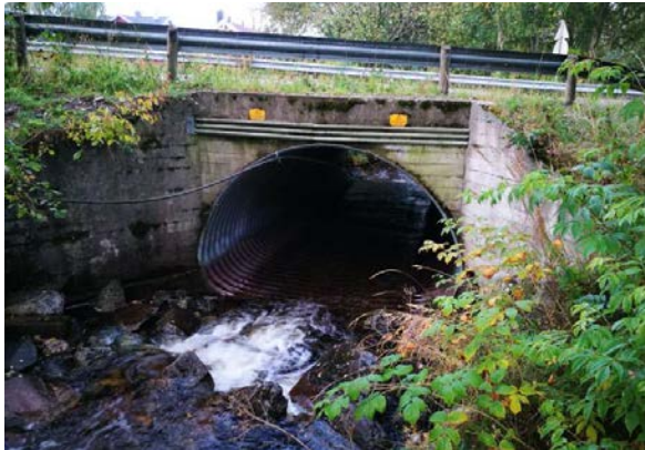
Messa, kulvert under Fv. 501.
