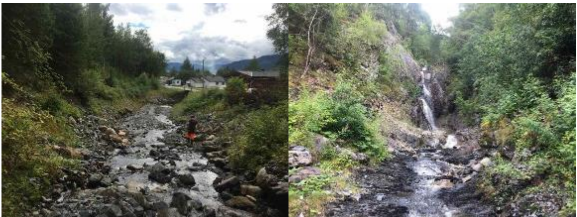
Figur 22. Grøta oppstrøms kulvert.
