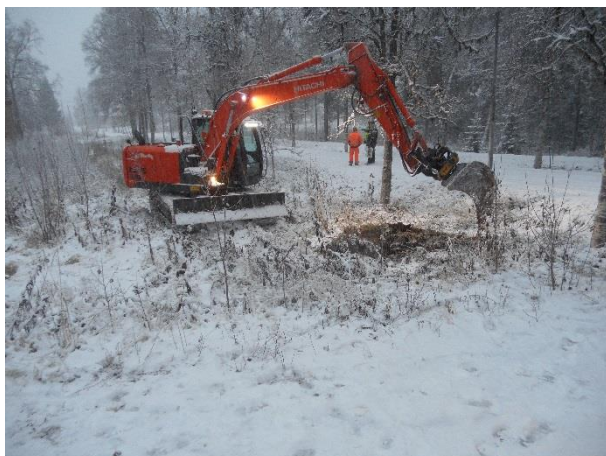
Figur 5. Graving av sjakt i område 1.
