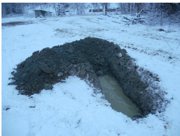
Figur 9. Høyt grunnvann på kjørareal vest i område 3..
