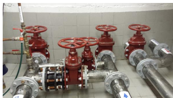
Figur 4 Ventilkammer Å høydebasseng
