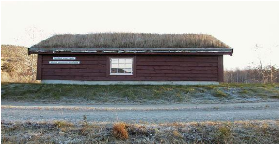
Figur 2 Meldal vannverk - Muan pumpestasjon
