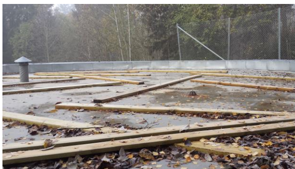
Figur 7 Taket på Å høydebasseng
